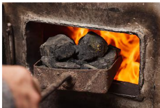
Rechargement en houille d'une chaudière à charbon
